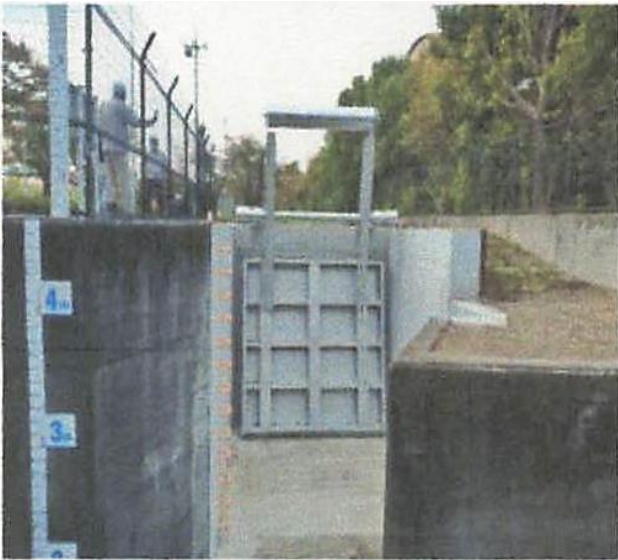
根川第1雨水幹線への逆流防止ゲートの設置
