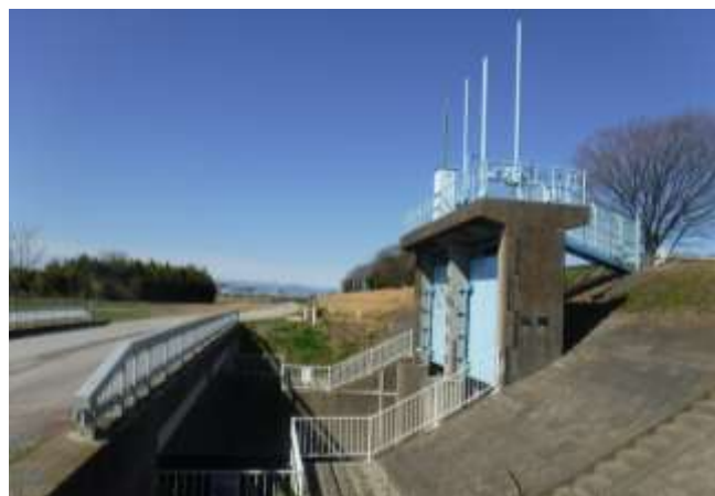
調布排水樋管
