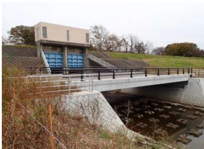
六郷排水樋管
