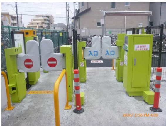
図 12 ゲート式システムの例 (つつじヶ丘駅南口西自転車駐車場)
