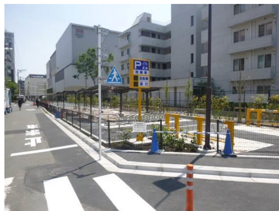
図 15 調布市立調布西第2路上自転車等駐車場
