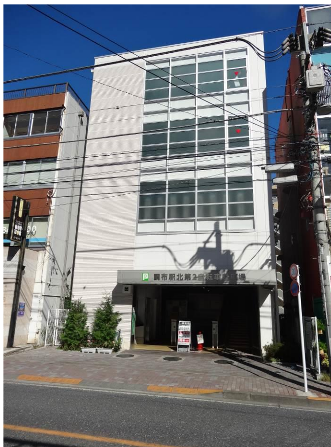
図 7 調布駅北第2自転車駐車場
