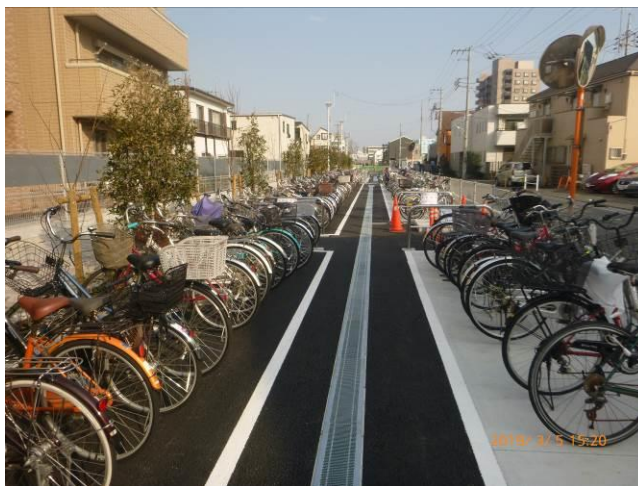
図9 調布市立調布東第2路上自転車等駐車場
