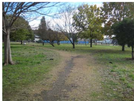
土系舗装による園路 (史跡勝坂遺跡)
