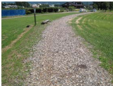
ウッドチップ舗装園路 （史跡平出遺跡：長野県塩尻市）
