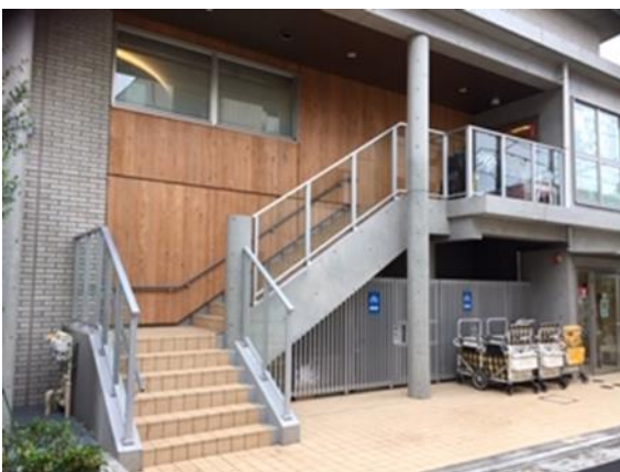
パイオニアキッズ柴崎園（平成30年4月開園）
