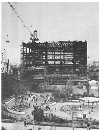
市民福祉会館工事風景
