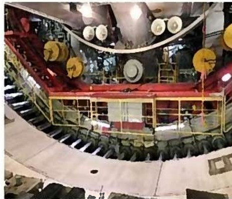
写真2 坑内状況写真(マシン下部)
