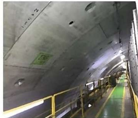
写真5 坑内状況写真(空洞発見箇所付近セグメント状態)
