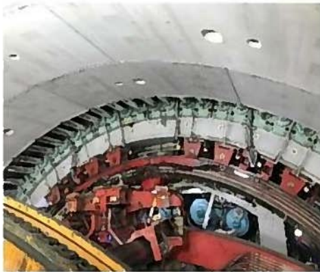
写真1 坑内状況写真(マシン上部)
