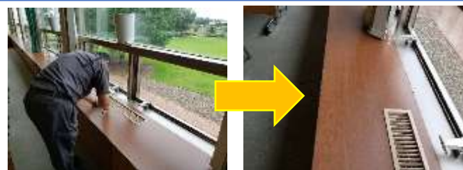
中講座室の空調吹き出し口 不具合修繕
