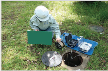
地下水位の観測状況
