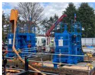
地盤補修マシン 地盤の削孔および改良体の造成
