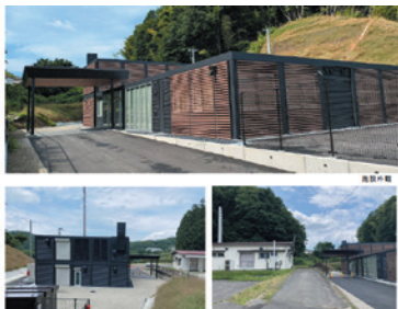
ユニットハウス式川俣町斎場 (福島県) 出典：火葬研究28
