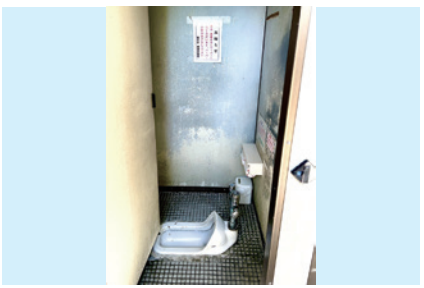
調布市最古の公衆トイレ「京王多摩川駅南公衆トイレ」
