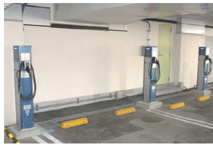
市庁舎に設置された電気自動車用の充電設備 (公用車用)
