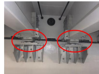
上部工と下部工をケーブル等による連結によって地震時の落橋を防止する。
