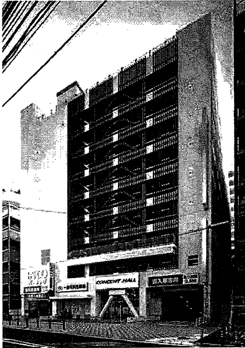
調布駅北第1B地区 施設建築物外観
