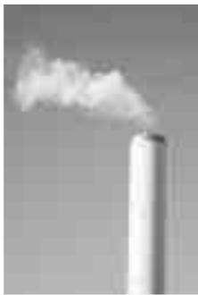
白煙を目立たなくする為、白煙防止装置がありますが、設置をすると、排ガスを再加熱する
