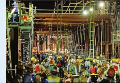
地下化切換工事の様子(西調布方取付部)
