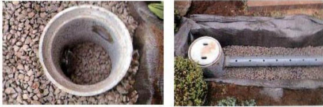
浸透ますと浸透トレンチを設置し埋め戻す前の様子（左：浸透ます，右：浸透トレンチ）
