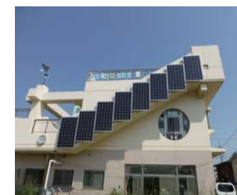
調布市多摩川自然情報館の壁面に設置した太陽光パネル
