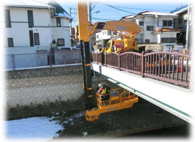
橋りょう点検車を使っでの点検
