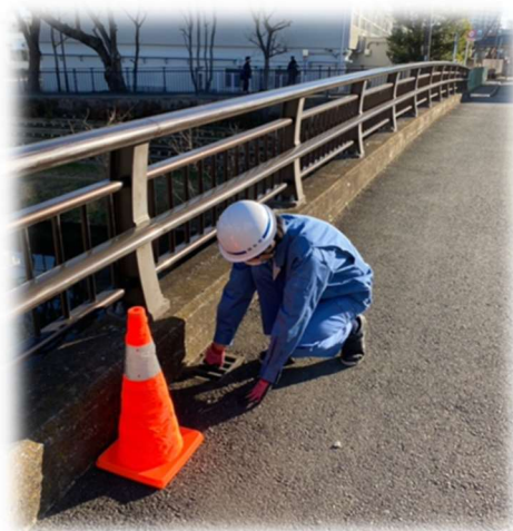
橋りょう上に堆積した土砂撤去や排水桝の清掃の様子
