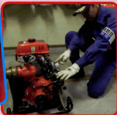
可搬ポンプの動作確認を行う
