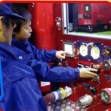
火災に備え点検を欠かさない
