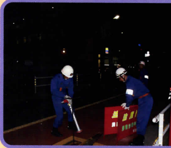
消火栓からの注水&交通整理
