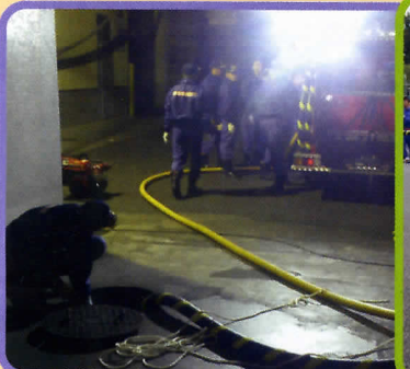
吸水管を延ばし吸水を行う
