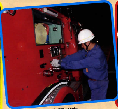
ポンプ車の動作確認中
