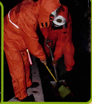
台風26号の排水対策での側溝掃除
