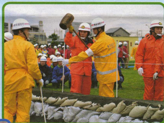
▲バイル（杭）を打ち込み固定する
