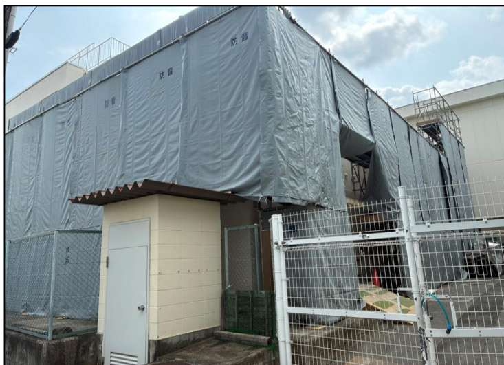
No.4 調布市立第二小学校給食室改修工事 外部仮設足場 設置状況
