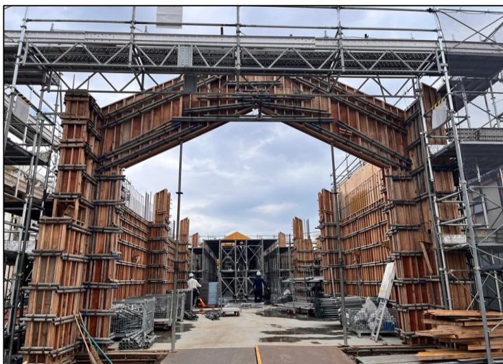
No.6 調布市立図書館宮の下分館改築工事 地上1階躯体 施工状況
