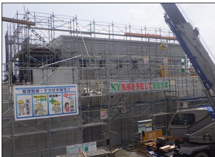
No.5 (仮称)調布市国史跡下布田遺跡ガイダンス施設新築工事 地上2階躯体 施工状況
