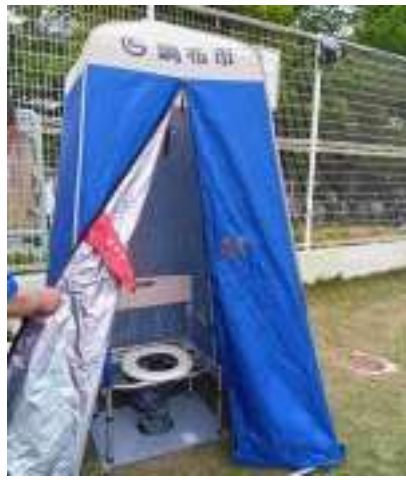
▲マンホールトイレ（調和小）
