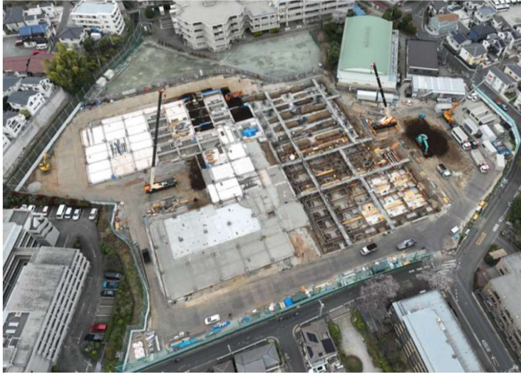
No.1 調布市立若葉小学校・第四中学校・ 図書館若葉分館施設整備PFI事業 基礎及び1階床 施工状況
