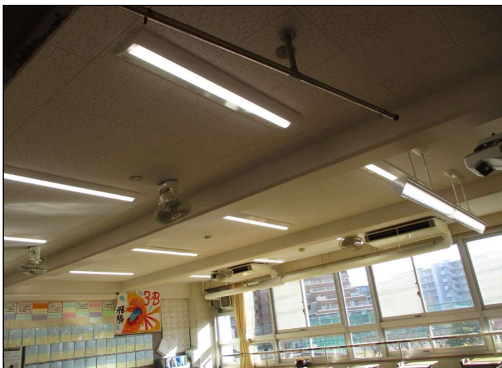
No.3 調布市立第五中学校校舎LED化改修工事 LED照明器具 設置完了
