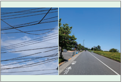
電線の広がる空（左）と 無電柱の道路（右）
