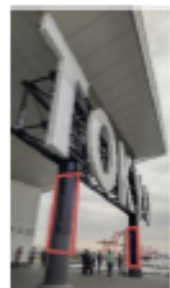
柱に設置した次世代型ソーラーセル
