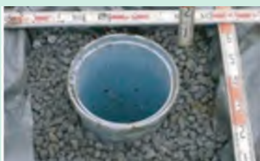
■宅地への雨水浸透ますの設置
