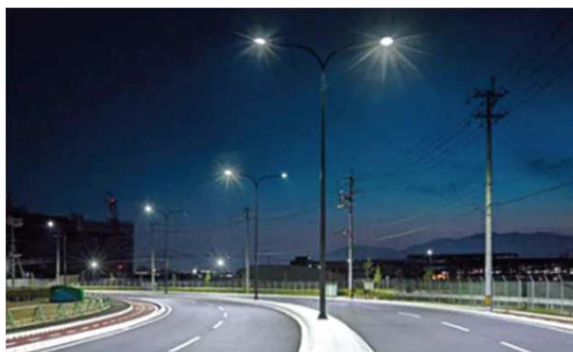
図 LED照明導入による消費電力削減
