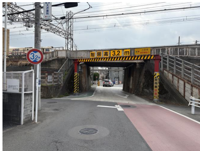
調布3・4・9号線の鉄道交差点(清水架道橋)
