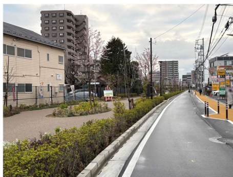
市道S104号線(調布駅～布田駅間)
