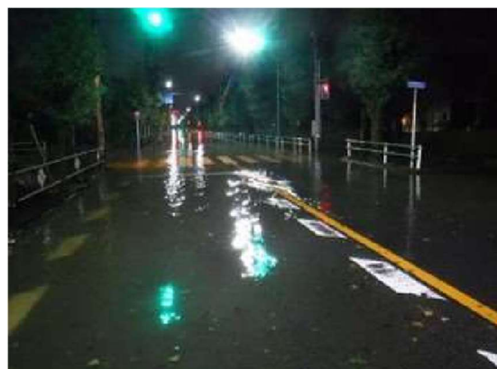
市内における台風による道路冠水の状況
