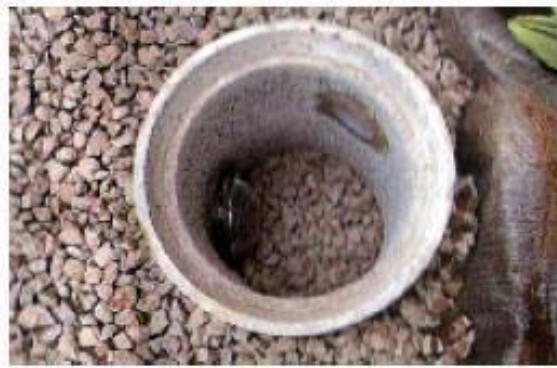
浸透ますと浸透トレンチを設置し埋め戻す前の様子（左：浸透ます，右：浸透トレンチ）
