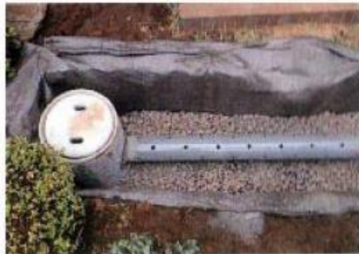
浸透ますと浸透トレンチを設置し埋め戻す前の様子（左：浸透ます，右：浸透トレンチ）
