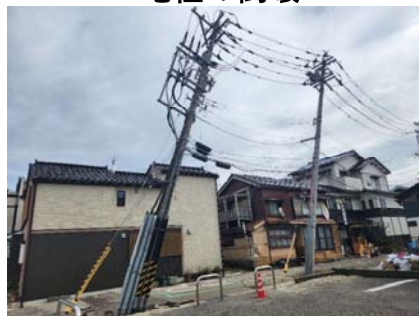
電柱の倒壊
