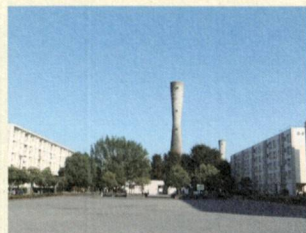
多摩川住宅と給水塔
