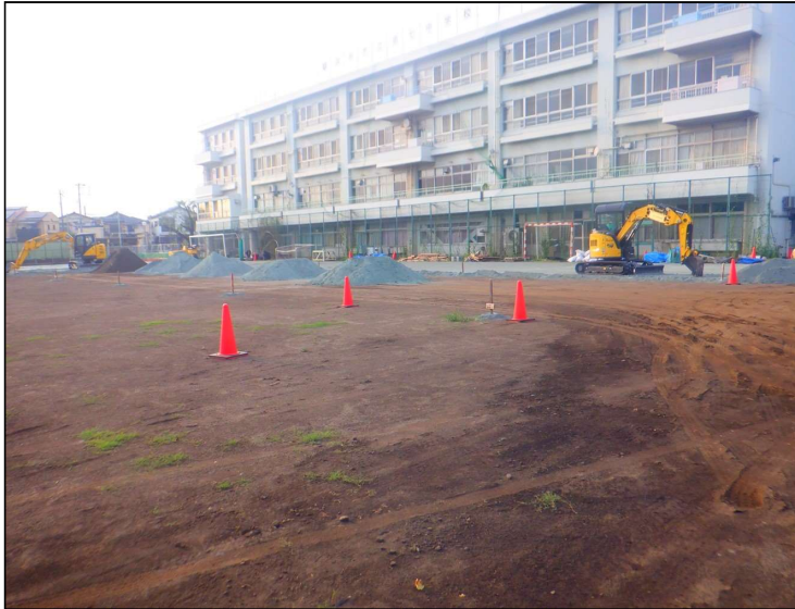
No.4 調布市立第七中学校校庭整備工事 校庭内 施工状況
