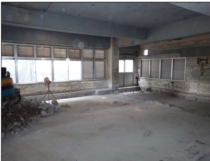
No.2 調布市立富士見台小学校給食室改修工事 給食室内部撤去 施工状況
