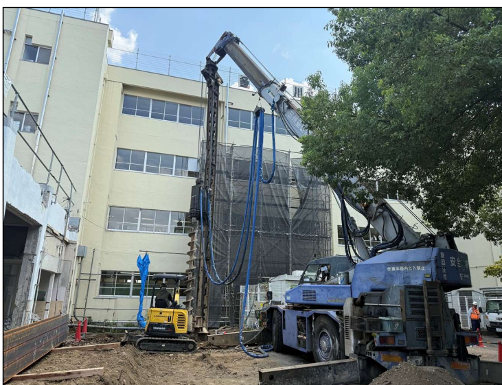
No.3 調布市立多摩川小学校給食室改修工事 給食室増築部基礎 施工状況
