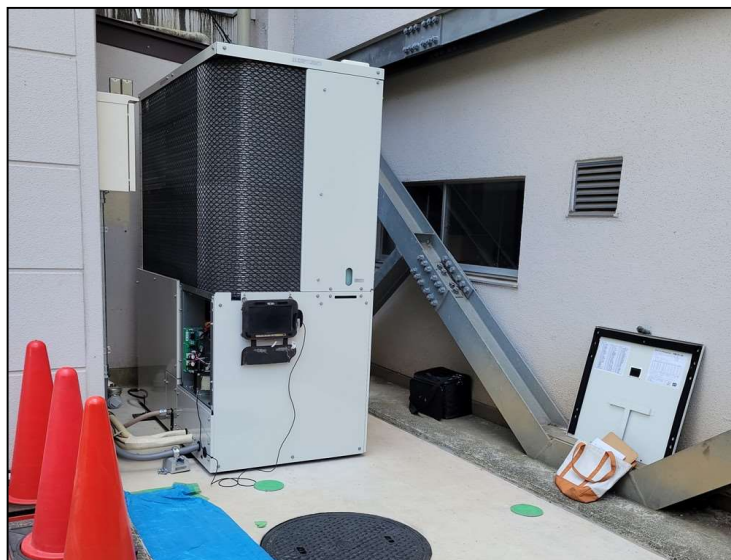
No.6 調布市立深大寺小学校普通教室空調機更新工事 空調室外機 設置状況
