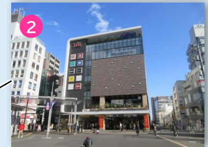
京王線連続立体交差事業（H16～H26年度）により創出したトリエ京王調布A館
