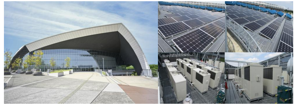
太陽熱を利用した省エネとBCP対策を両立した京王アリーナTOKYO
