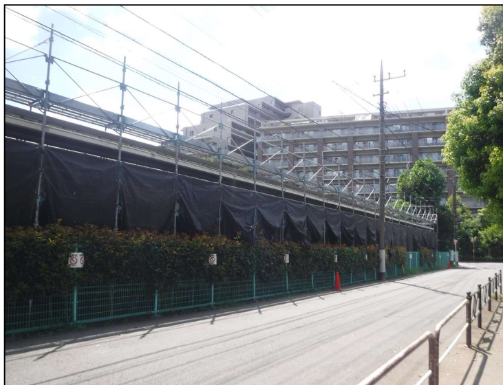
No.6 調布市立上ノ原小学校北校舎外部改修工事 仮設足場 設置状況
