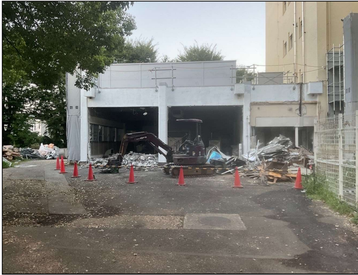
No.4 調布市立多摩川小学校給食室改修工事 給食室外部撤去 施工状況
