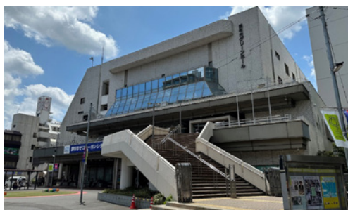
新たなグリーンホールの整備検討
