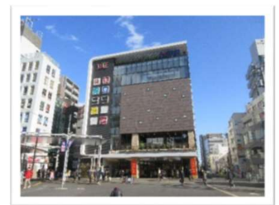
京王線連続立体交差事業（H16～H26年度）により創出されたトリエ京王調布A館
