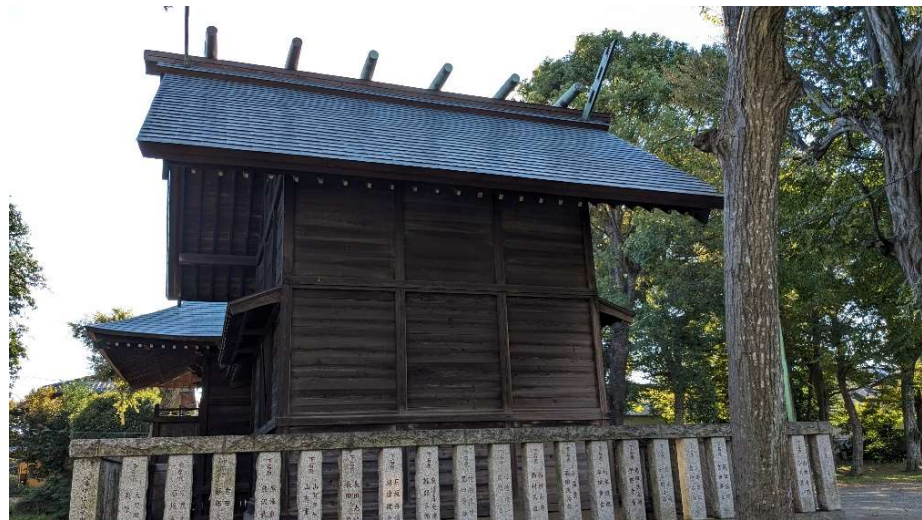
本殿覆屋背面
