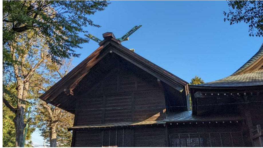
本殿覆屋側面
