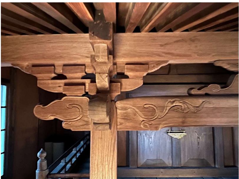
本殿向拝 左 柱・水引虹梁・斗拱・木鼻・ 軒桁・繁垂木
