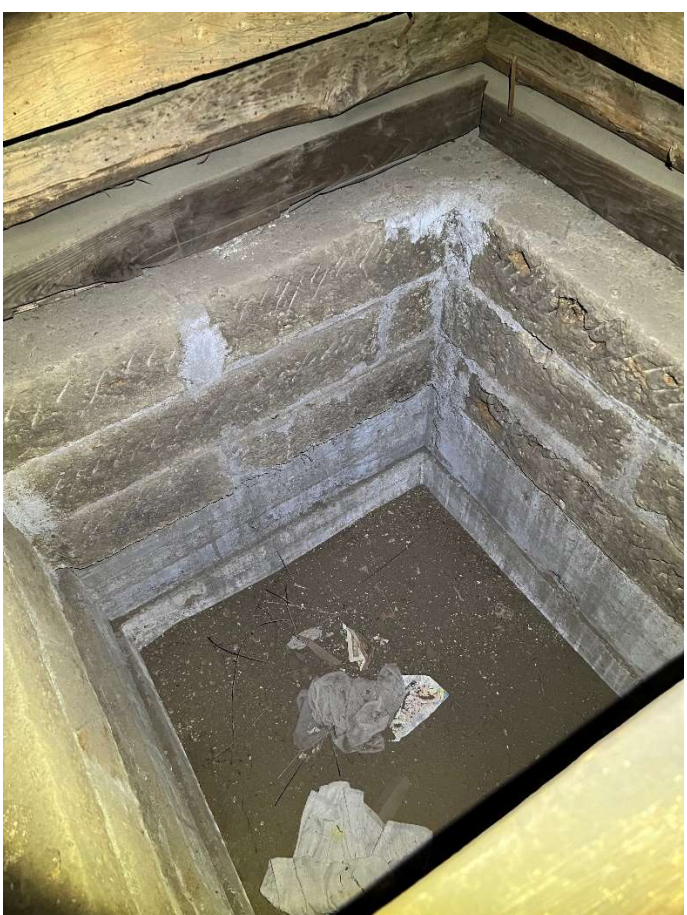
土台は石積み基礎に乗せている
