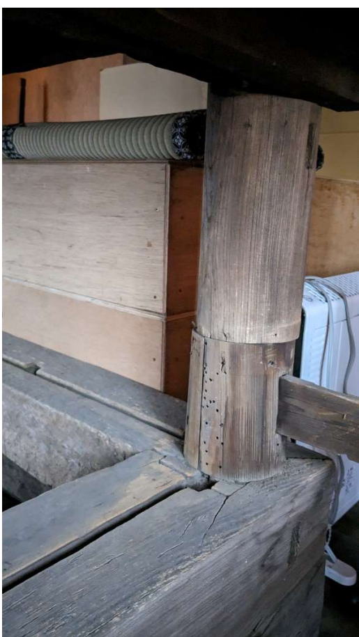
身舎床下の柱は全て根継ぎされて、土台に据えられる
