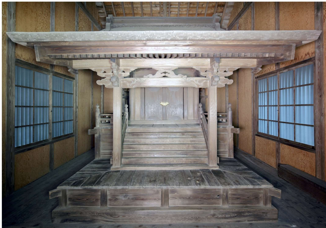
本殿 柿葺き 浜縁 柱 梁 斗 栱 など主要部材は檜造
