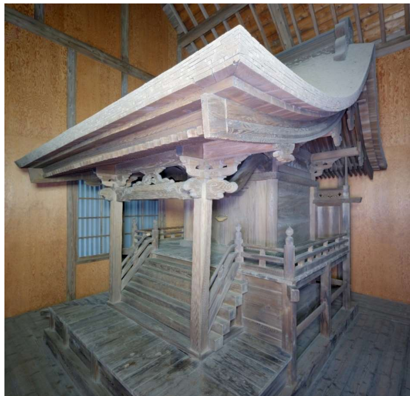
柿葺き屋根の曲線は素晴らしい
