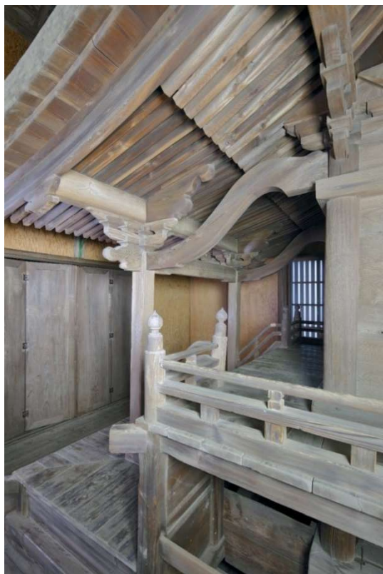
本殿 向拝 軒は二軒 海老虹梁で身舎とらなぐ
