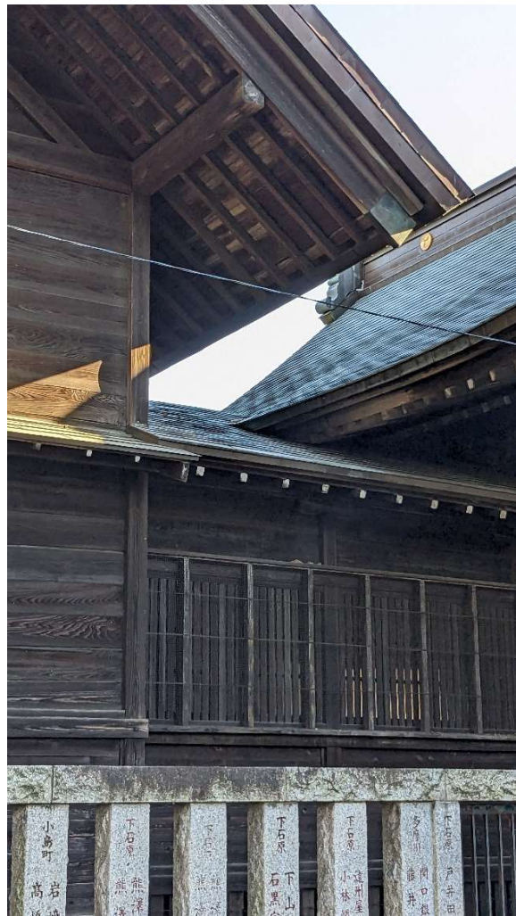
本殿覆屋と幣殿の収まり
