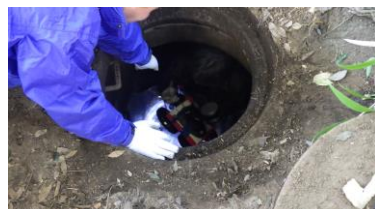
農業用水路（地下）調査の様子
