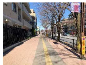
バリアフリー化された歩道
