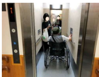
両側に車いす用操作盤が設置されたエレベーター
