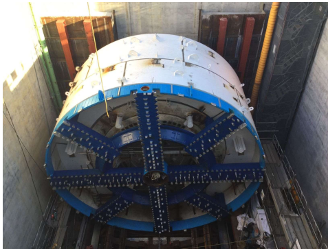
シールドマシンの組立状況 (平成30年12月19日)
