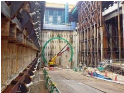
工事の写真(イメージ)
