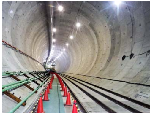
トンネル内部の写真(イメージ)
