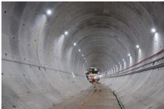
トンネル内部の写真(イメージ)
