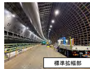
東名JCT地中拡幅(南行)の現地状況
