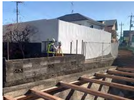
変状調査（測量）
