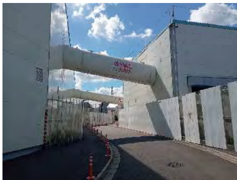
ベルトコンベアの状況 (令和7年7月30日)
