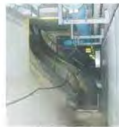
すべり台(路面下から)
