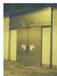
首都高速中央環状新宿線の例
