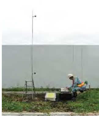
騒音、振動測定状況
