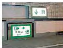
路面下への非常口(路面から)
