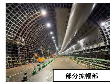
東名JCT地中拡幅(南行)の現地状況
