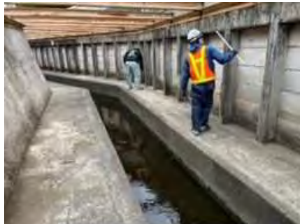
変状調査（点検）
