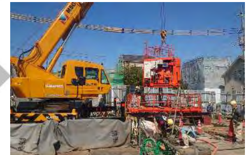
地盤補修マシンの据付
