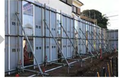
仮囲いの設置
