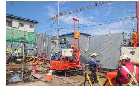
削孔・地盤改良体造成 (小型の地盤補修マシン)
