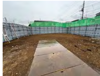
家屋解体完了
