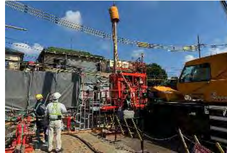
削孔・地盤改良体造成 (通常の地盤補修マシン)
