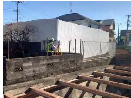
変状調査（測量）
