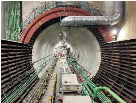
坑内の状況 (令和7年7月30日)
